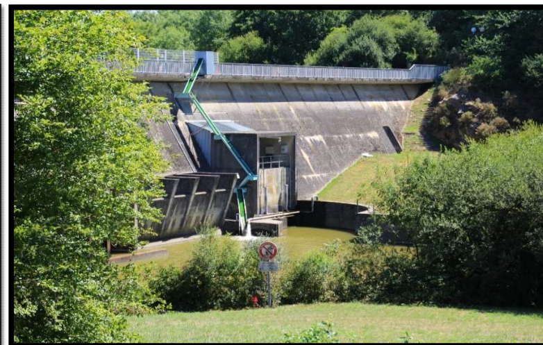
Barrage de la retenue de Rochereau. Photographie prise par le SMMPBL, juillet 2017
